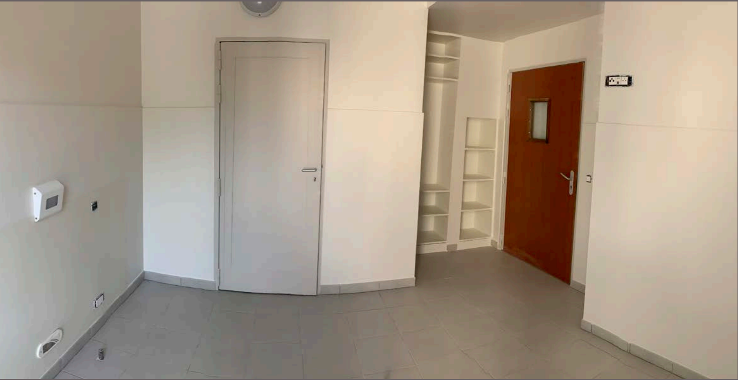
Photos de l'espace mis à disposition pour l'expérimentation : ancienne chambre sécurisée (le lit scellé a été déposé) avant travaux
